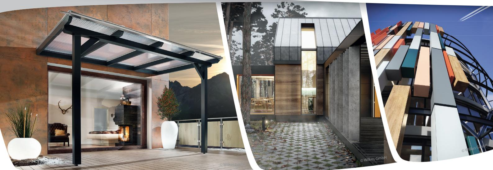
Mit HPL-Baukompaktplatten von Kronoplan sind der kreativen Baugestaltung keine Grenzen gesetzt: Das umfangreiche Sortiment an Farben, Strukturen und Formaten ermöglicht ein hohes Maß an architektonischer Freiheit. Die Platten punkten mit dem beidseitigen Dekor und dem beidseitigen UV-Schutz – so garantieren sie einen langjährigen Einsatz besonders bei Außenanwendungen. Die leichte Be- und Verarbeitung machen sie zu einem begehrten Baumaterial für farbige und strukturierte Fassadengestaltungen.
